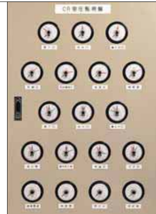
クリーンルーム室圧監視盤
